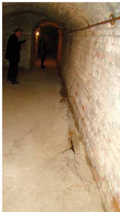
Фото №№ 6,7. Фрагменты помещений объекта культурного наследия регионального значения «Усадьба Шереметевых. Главный дом». Фото слева: вход в центральную часть подвальных помещений. Фото справа: разрушение (вспучивание) цементного пола подвальных помещений. Фото 11.2012 года.
